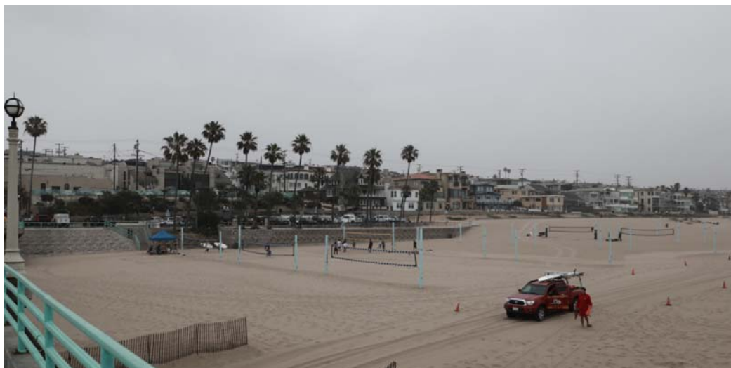
Blick vom Strand auf den Bauplatz ...leider bei regnerischem Wetter
